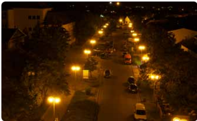
Obr. Senec - Pred rekonštrukciou
