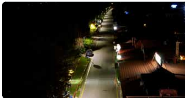
Obr. Senec - Po rekonštrukcii
