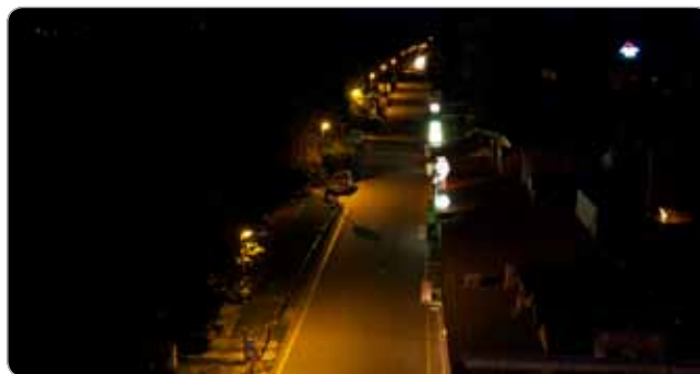
Obr. Senec - Pred rekonštrukciou
