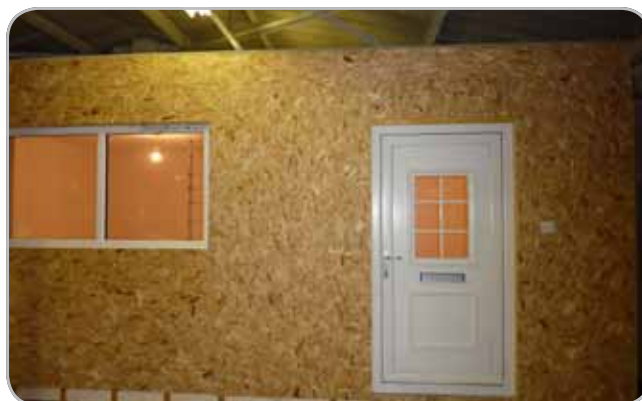
Obr. 4 Okno v testovanej miestnosti 1700 x 990 mm UPVC dvojité sklo U-hodnota: 1,79W/m 2 K
