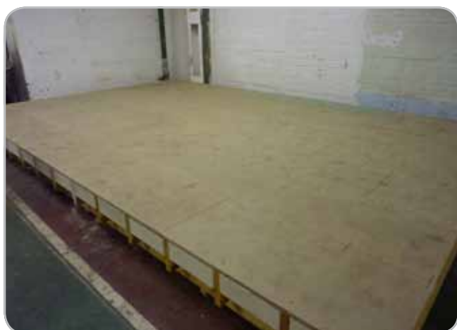
Obr. 1 Štruktúra podlahy 220×45 mm drevené nosníky, 120 mm Kingspan 22 mm drevotriesková doska, 6 mm depronová izolácia 15 mm konštrukčný podlahový materiál U-hodnota: 0,18W/m 2 K
