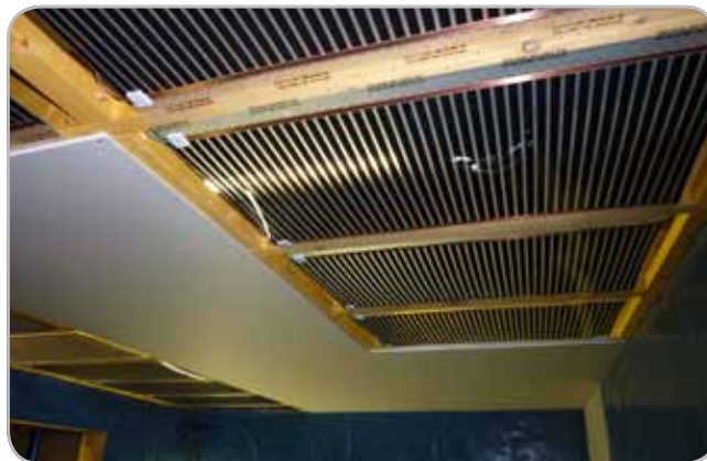
Obr. 3 Konštrukcia stropu 220 x 45 mm drevené nosníky, 12,7 mm sadrokartón vykurovací prvok Ecofilm (500/600 Typ C) 200 mm izolácia, 22 mm drevotriesková doska hore U-hodnota: 0,19W/m 2 K
