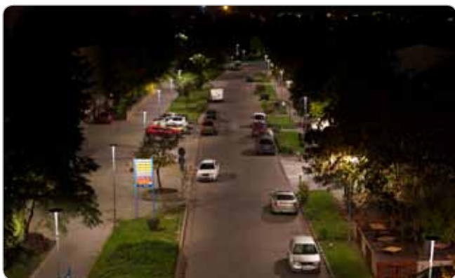
Obr. Senec - Po rekonštrukcii
